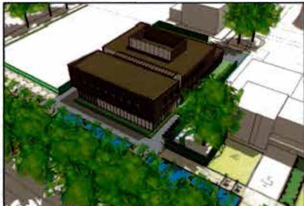
De voorgevel van het nieuwe pand (vanuit noordwestelijke richting)
