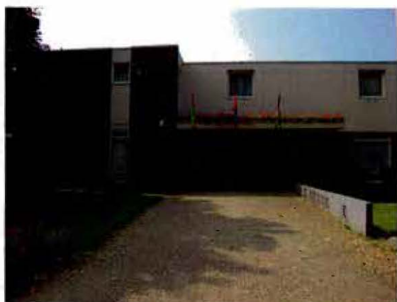
Het naastgelegen ontmoetingscentrum 'Aan de Wan'
